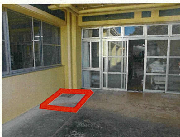
・非常用自家発電設備設置予定場所
