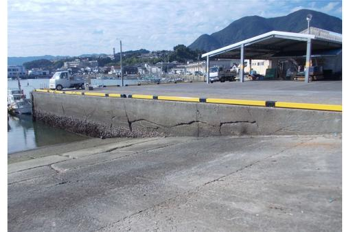
老朽化により発生したひび割れ
