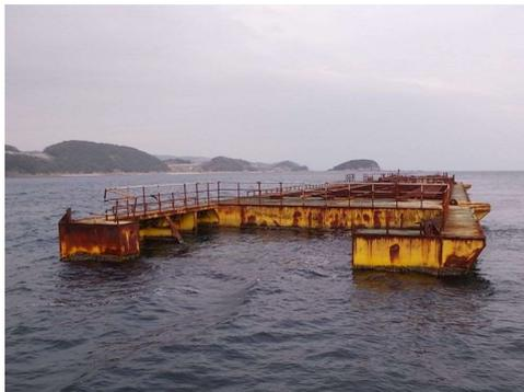
浮消波堤（鋼製）
