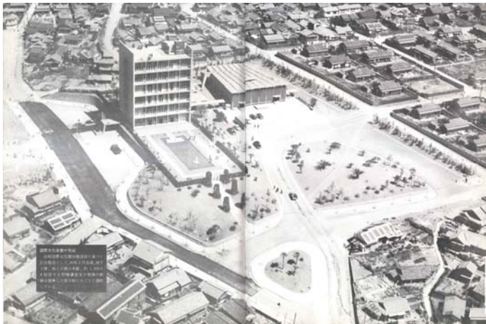
長崎国際文化会館 （昭和 30 年 2 月完成）
