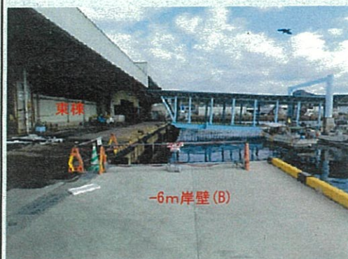
撮影：令和4年1月（-6m岸壁(B)）
