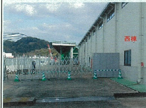
撮影：令和4年1月（-6m岸壁(C)）
