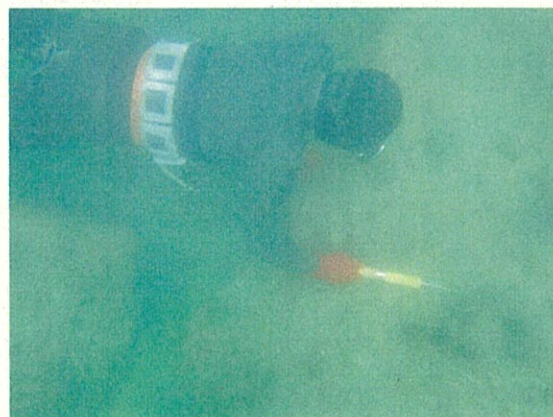
潜水による除去作業
