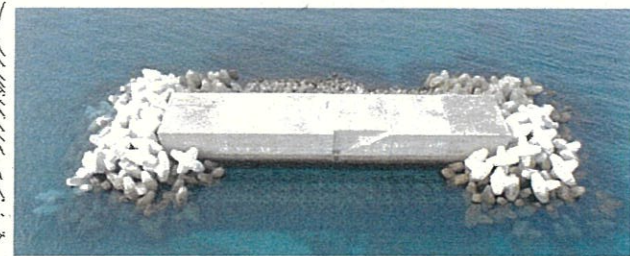
沖防波堤 現状写真 (R4.1)
