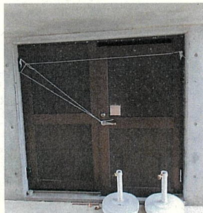
(階段下倉庫扉)
