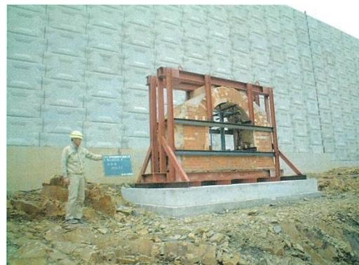
写真 1-70 保存用に切断された導水隧道
