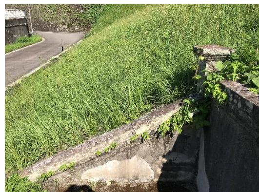
写真 2-81 踊り場の側面の剥離
