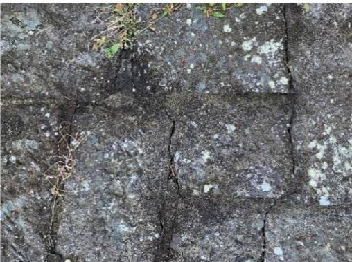
写真 2-37 天端の目地部分の劣化
