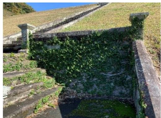
写真 2-10 側面に繁茂したかずら
