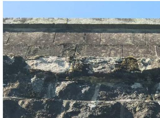
写真 2-36 上流面の石材の剥離
