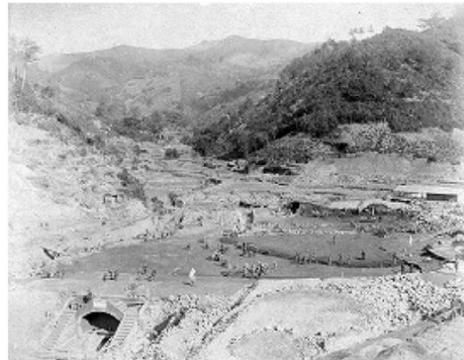
写真 3-33 本河内高部浄水場土堰堤工事
