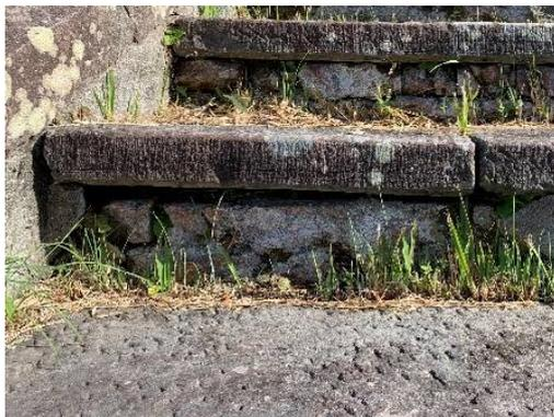
写真 2-7 踏み石の浮き、ずれ
