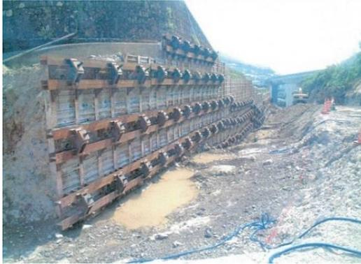
写真 2-13 土留工による補強
