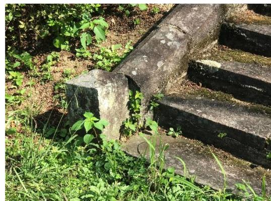
写真 2-97 石段の親柱の傾斜
