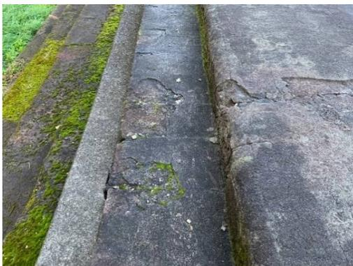
写真 2-43 余水吐き頂部の劣化
