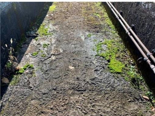
写真 2-39 舗装部分のモルタル
