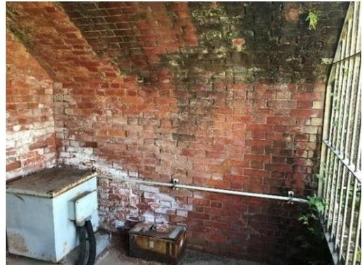
写真 2-18 上部漏水により劣化した内部
