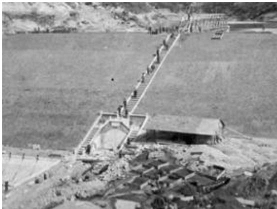
写真 1-22 完成直後の弁室及び中央階段
