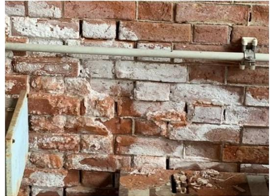
写真 2-83 砂状化した煉瓦表面
