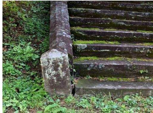
写真 2-75 傾いた下段左部の石柱
