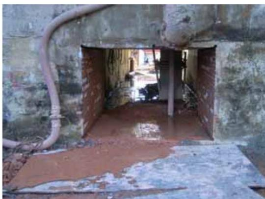
写真 1-77 ワイヤーソーによる切断
