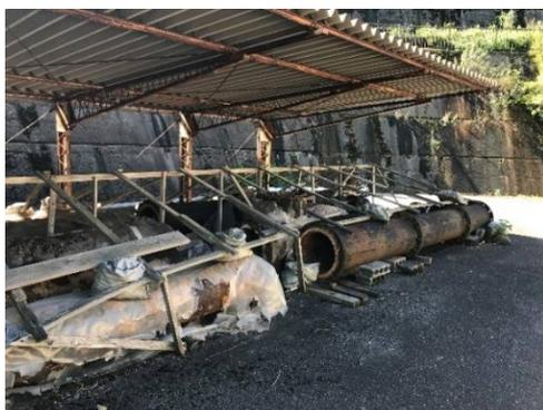
写真 5-16 低部堰堤の取水管
