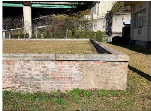
写真 2-24 南面のモルタルの剥離
