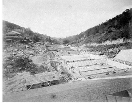
写真 3-41 本河内高部浄水場濾過池・配水池工事
