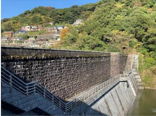
写真 1-79 打ち増し部の仕上げ
