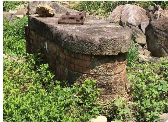
写真 2-95 風化が進む旧鉄管橋梁橋脚
