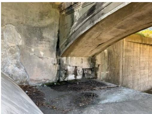
写真 2-53 側端部のひび割れ
