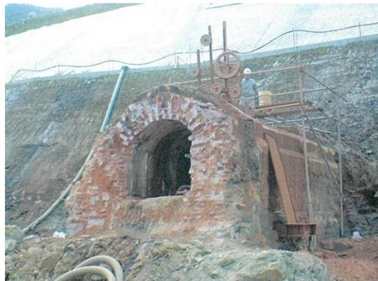
写真 1-72 ワイヤソーによる導水隧道切断
