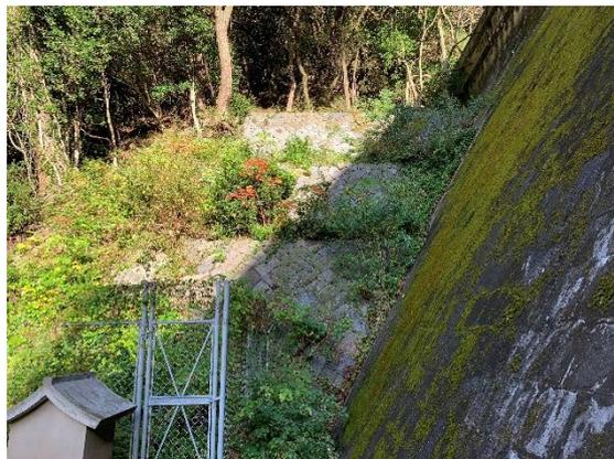
写真 1-14 低部堰堤右岸石積三段
