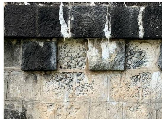
写真 2-89 表面の砂状劣化
