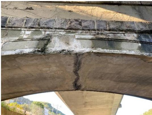
写真 2-92 径間中央部のひび割れ
