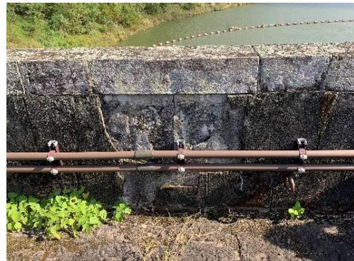
写真 2-38 天端側壁のモルタル剥離
