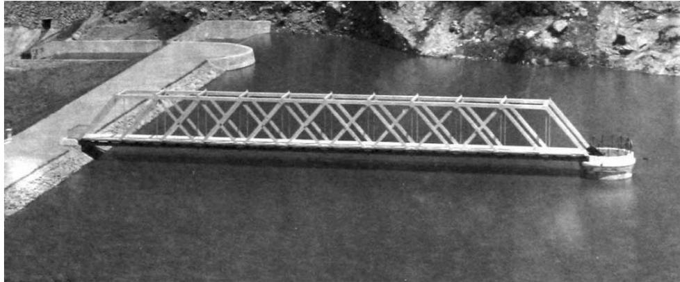
写真 1-29 引水塔及び検査用橋梁
