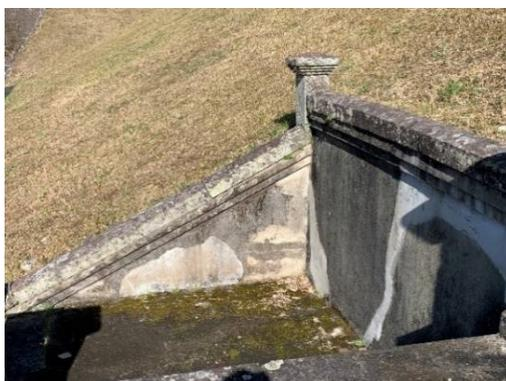
写真 2-9 側面のモルタルの剥離
