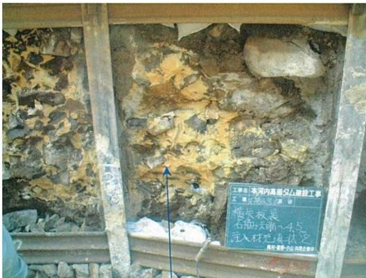
写真 1-71 石垣の薬液注入による補強
