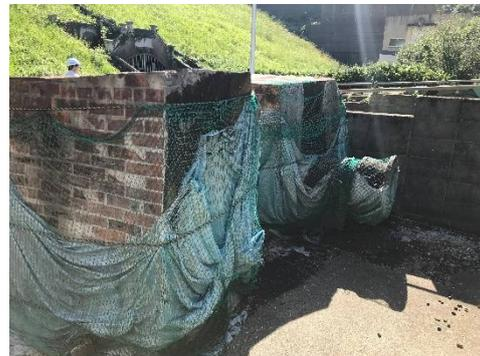
写真 3-79 取水塔下部切断部
