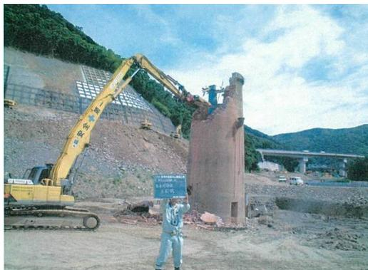
写真 1-69 引水塔残存部撤去
