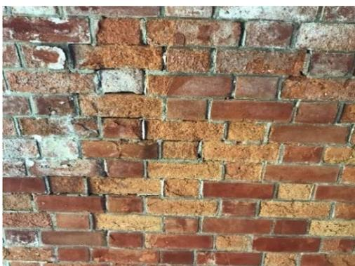
写真 2-19 弁室内部の煉瓦の砂状劣化
