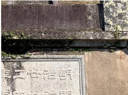
写真 2-17 弁室上部の隙間
