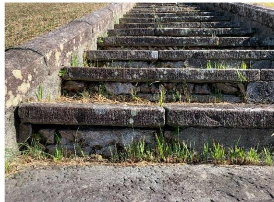
写真 2-79 蹴込板のモルタルの剥離
