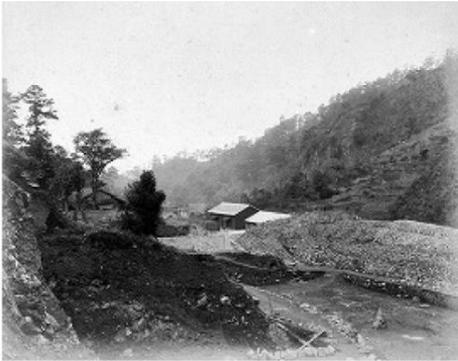
写真 3-40 本河内高部浄水場配水池掘削
