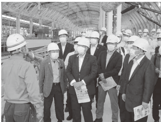
長崎駅新幹線駅舎の現地調査(建設水道委員会)
