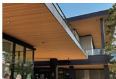
軒天井（木仕上げ）
