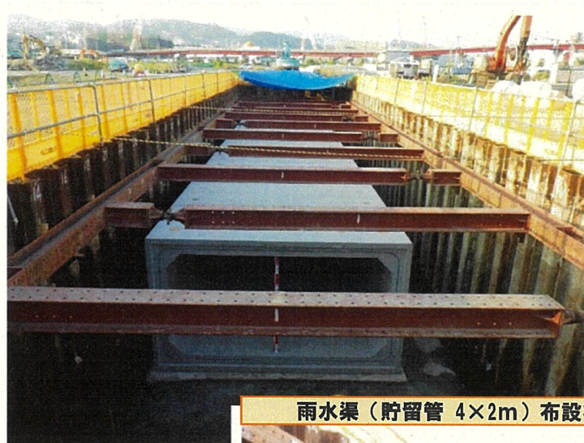
【開削工法】地面の上から直接掘削する一般的な工法
