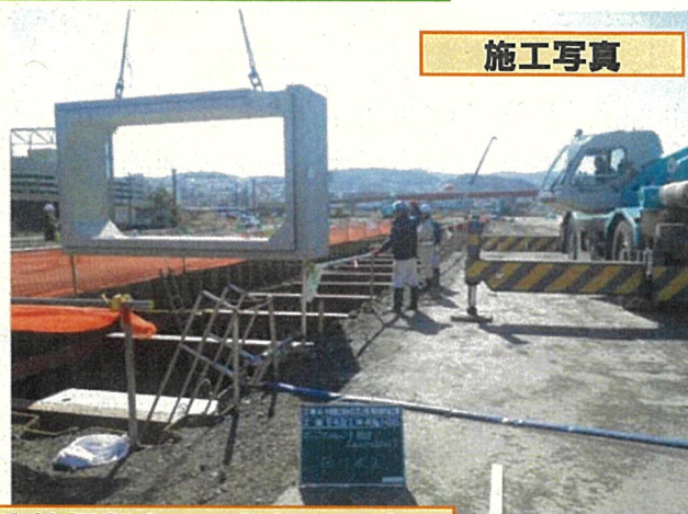
【開削工法】地面の上から直接掘削する一般的な工法
