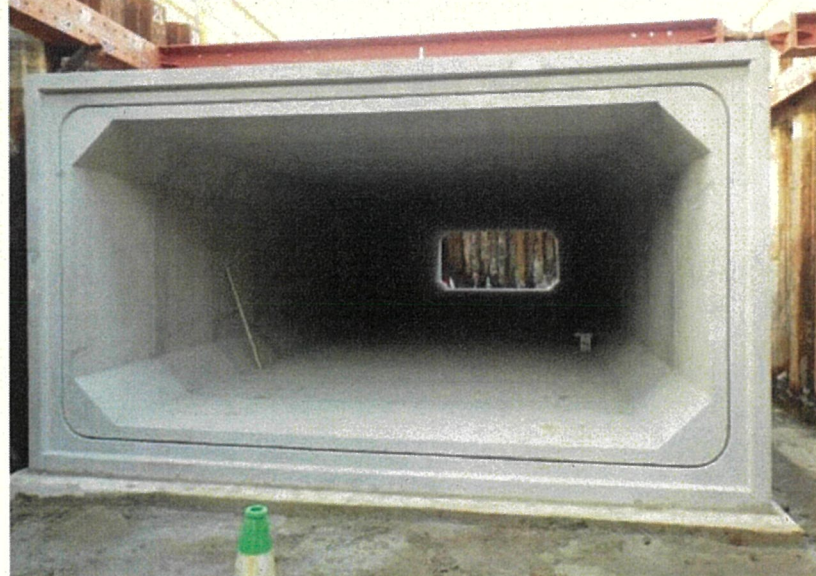
雨水渠（貯留管 4×2m）布設状況
