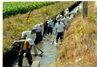
水路の泥上げ
