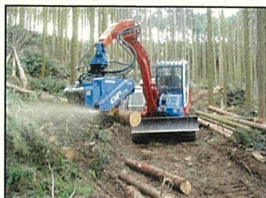
間伐作業（既存補助）山林整備事業
