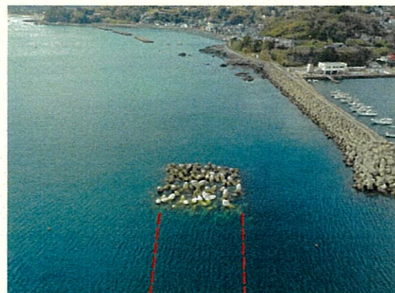
離岸堤 現況写真 (R2.1)
