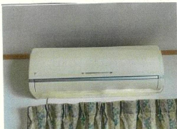
・経年劣化により故障が多く、一部部品が製造中止になっているエアコン
