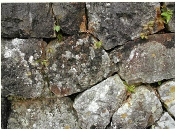
・基礎部分の土が流れ、空洞化した石垣
