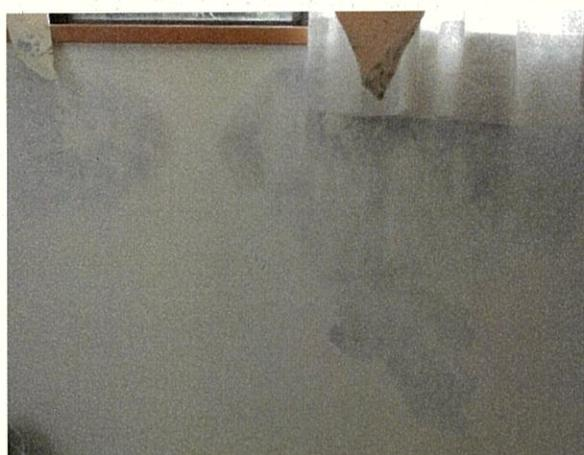
・外壁の目地コーキング裏側にヒビが入ったことで、裏側の壁に漏水し、カビが生えた室内壁
