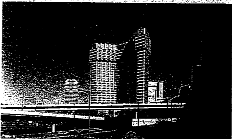
グランドプリンスホテル東区(旧)と東京プリンスホテルの解体工事の様子。解体には大成建設が関与した「テコレブシステム」を採用。屋上階の外観に防音パネルなどを取り付けて、騒音や粉じんを軽減しながら解体した(写真:小堀誠)
