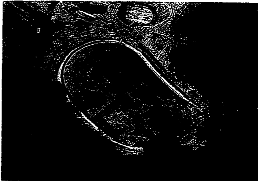
施工中の豊島美術館。支保工の代わりに土を盛って、その上に鉄筋を組んでコンクリートを流し込んだ。施工は豊島(写真：手塚 賢晴・由比)
