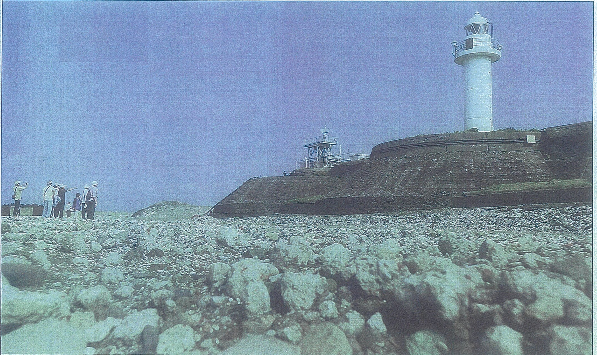
第二海堡の砲台跡。灯台が立つコンクリートには「FORT No.2」の文字が残っていた
