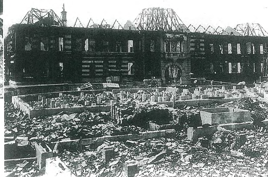
骨格だけが残った長崎県庁（風格あるルネサンス様式煉瓦造り石壁の建物であったが、熱線により中央ドームの屋根裏から発火。大火となって全焼した。） 〈小川虎彦氏撮影〉
