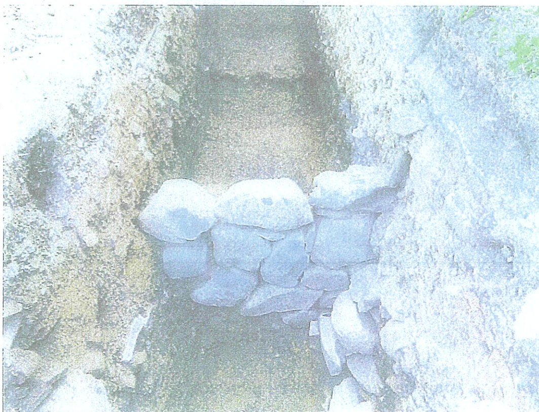
石垣検出状況（旧体育館の北側部分）
