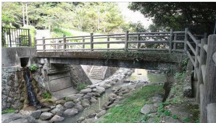
登録有形文化財 小ヶ倉ダム管理橋
