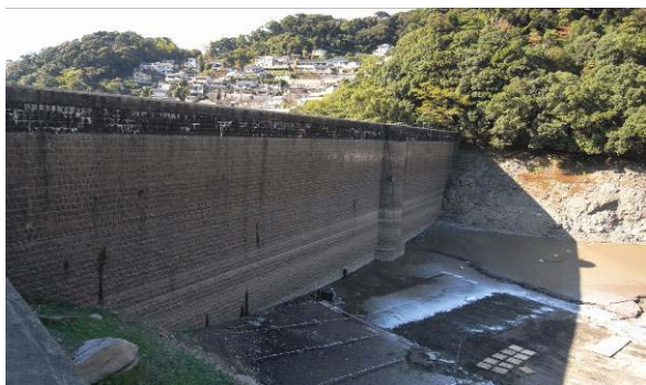
本河内低部ダム
