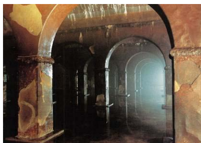
本河内高部 配水池内部
