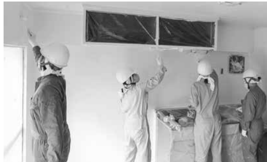
市営住宅の空き室の改修作業をする学生たち
