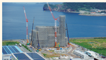
▲建設中の新西工場
