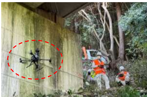
ドローンによる写真撮影状況①
