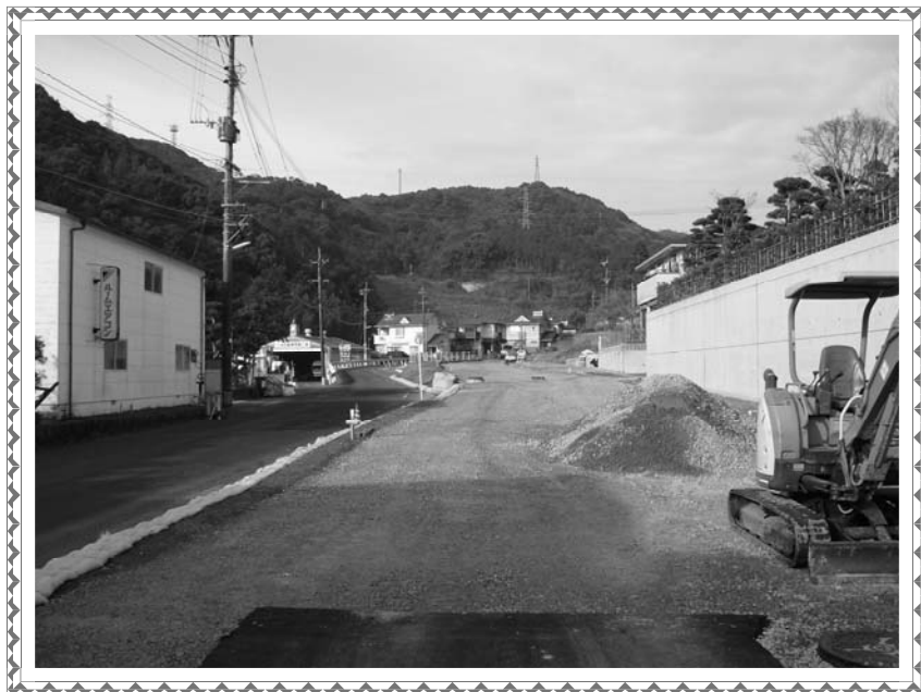
工事中の都市計画道路現川線
