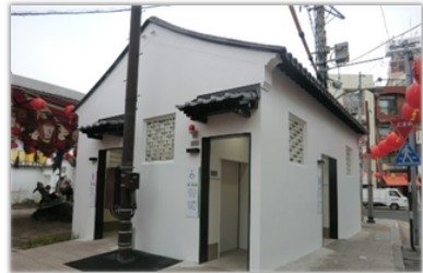
多目的トイレ整備 (H27 湊公園便所)
