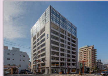
新大工町地区市街地再開発事業 (H25～R5 南街区R2.12完成)
