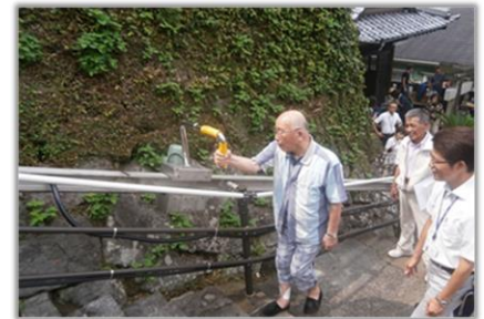
十人町一の組生活道路自動化プロジェクト
