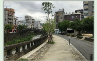
回遊路(歩道等)の整備 (R1 市道出来大工町桶屋町線)
