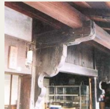
1階庇の持ち送り
