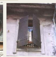
肘掛け窓の手すり
