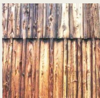
目板打堅羽目板張り
