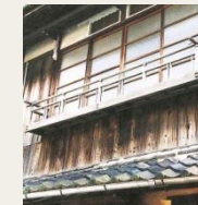
肘掛け窓の手すり
