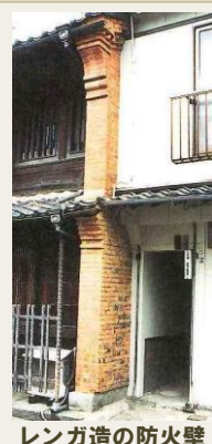
レンガ造の防火壁
