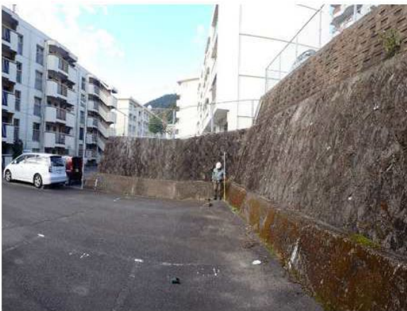
写真-6 周辺構造物 ボーリング No. 3 付近の混合擁壁。特に目立った変状は確認できない。
