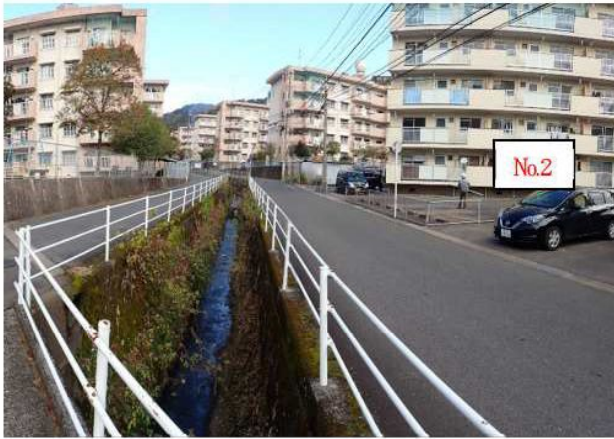
写真-4 周辺状況 都市下水路。ボーリング No. 2 付近より上流側を望む。 兩岸には市道が走る。
