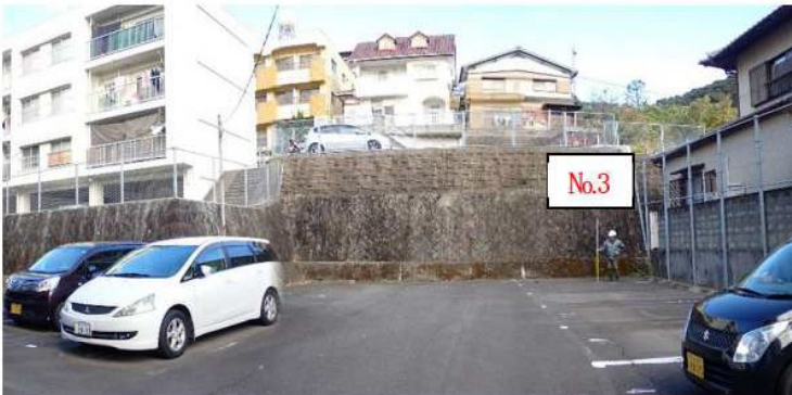
写真-5 ボーリング No. 3 階段状の斜面の末端部分。上部斜面は宅地化が進んでいる。
