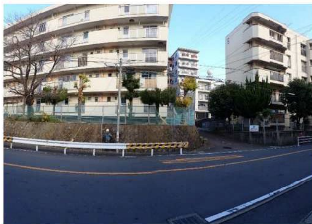
写真-9 周辺状況 市道よりボーリング No. 5 地点を望む。 市道より 2m 程度のブロック積擁壁が設置されている。
