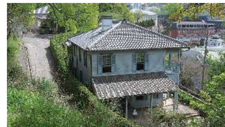
東山手の入口に建つ賃貸住宅
