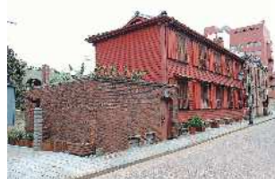
① 海に面して建つ煉瓦造りの建物。2階ベランダの柱と丸窓が特徴的。 ② 職員住宅など、敷地全体にわたり往時の姿を見ることが出来る。
