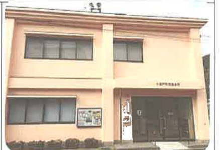
平成26年12月21日 西集会所改修工事完成(丸栄組)
