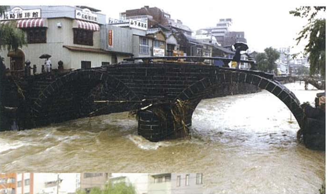
昭和57年の長崎大水害で、被害を受けた眼鏡橋。
