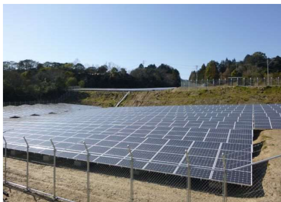
ながさきソーラーネット〔メガ〕三京発電所
