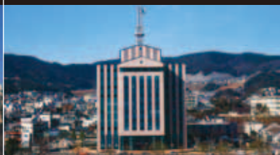
1995年 長崎電気ビル
