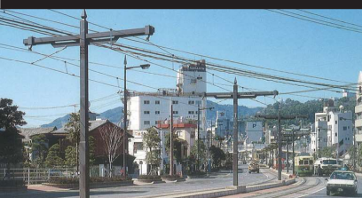
1989年 蜷茶屋から新大工までの電車通り・電気軌道中央柱
