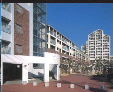
1993年 県営大橋団地・市営若葉団地
