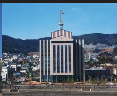
1995年 長崎電気ビル
