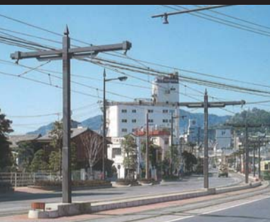
1989年 蛸茶屋から新大工までの電車通り・電気軌道中央柱
