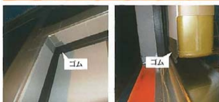
①上枠及び召合わせに設置した気密ゴム
