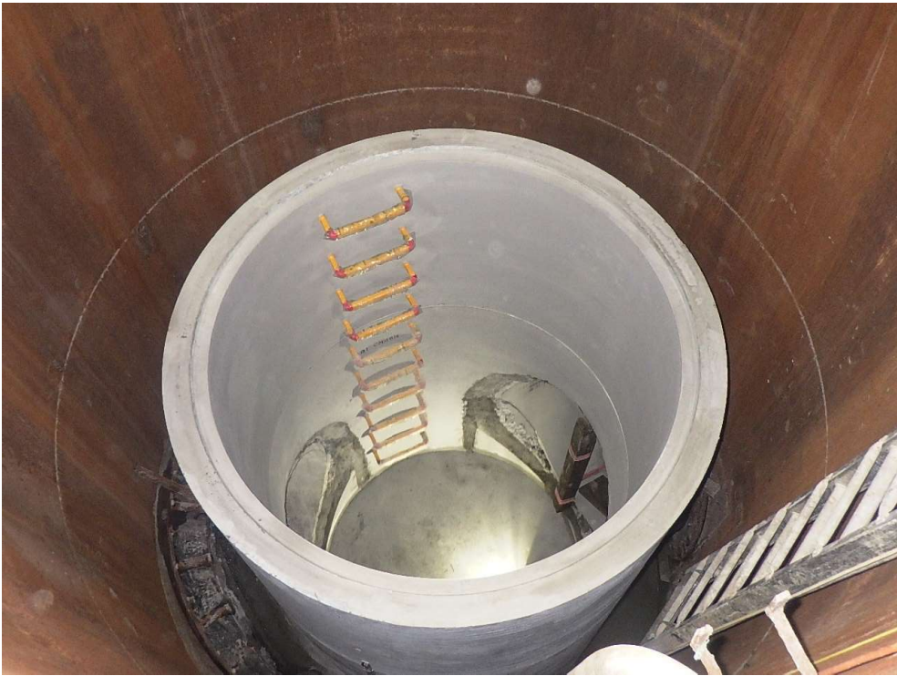
人孔築造状況
