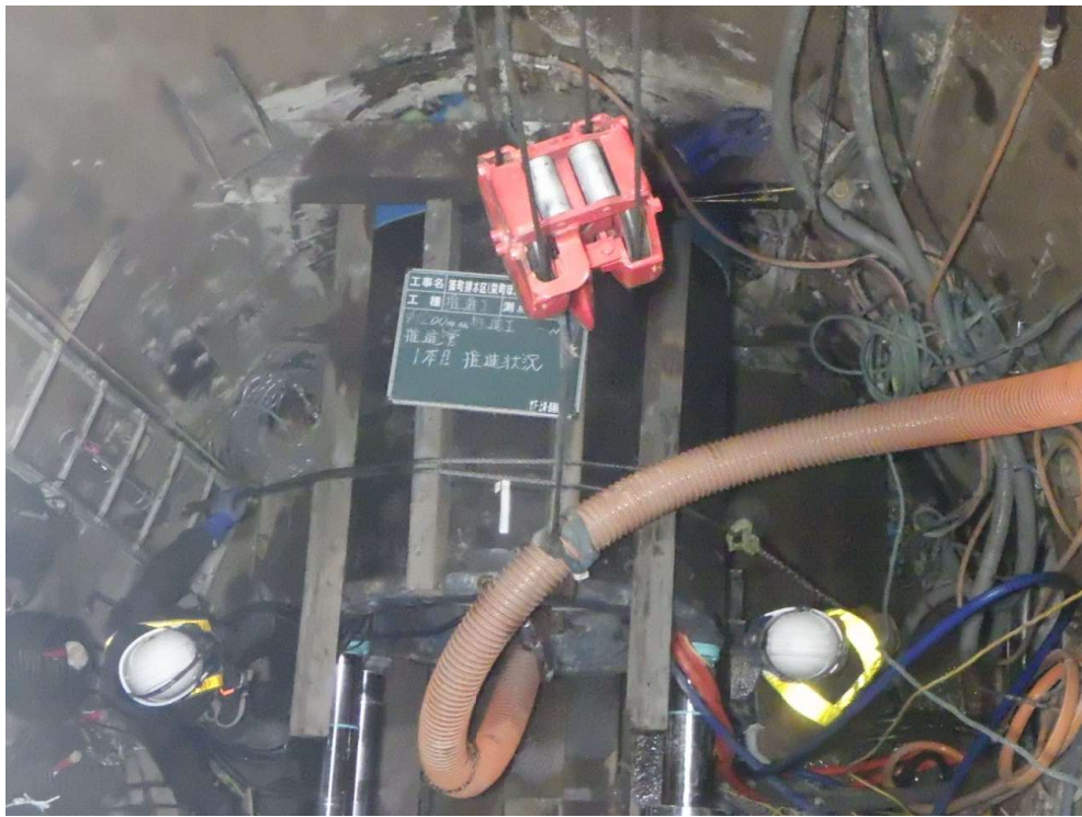
施工状況（推進工事）
