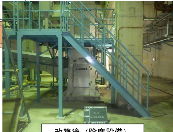
改築後 (除塵設備)
