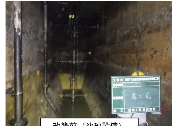
改築前 (沈砂設備)
