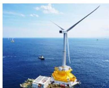
(浮体式洋上風力発電)
