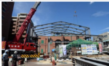
【本館・附属屋の素屋根解体工事】
