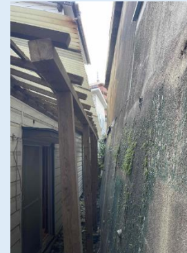
整備対象南側擁壁
