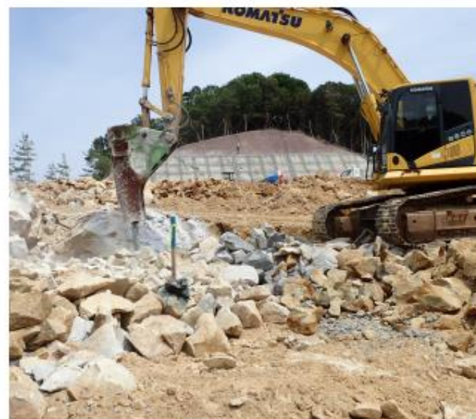
写真2 中硬岩掘削重機(ブレイカー付バックホウ)
