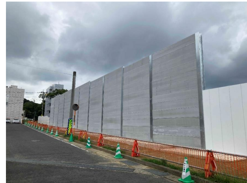
② 防音壁工
