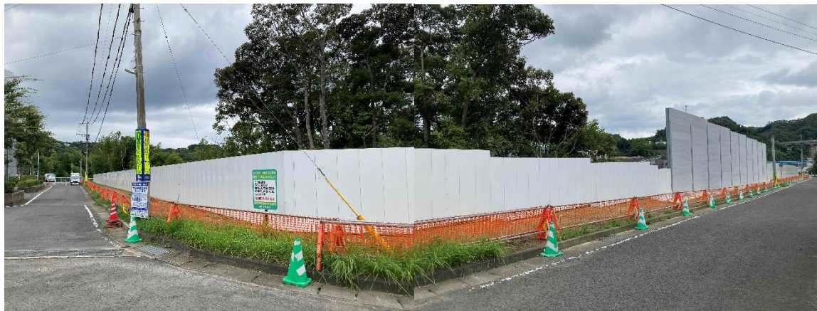
① 仮囲い工
