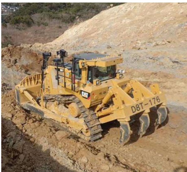
写真1 軟岩掘削重機(3本爪リッパ付ブルドーザー)
