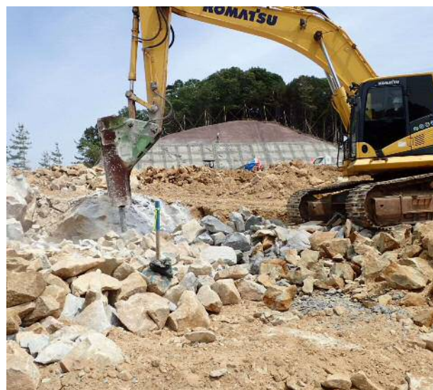
写真2 中硬岩掘削重機(ブレイカー付バックホウ)
