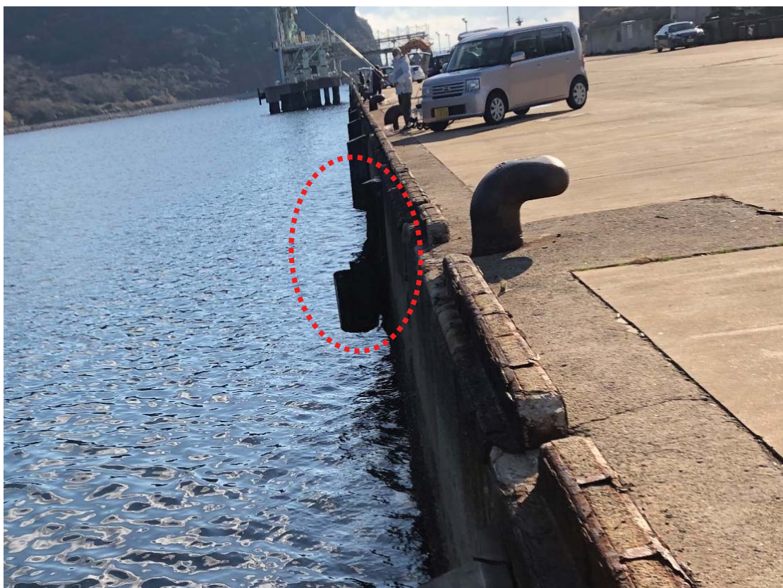
岸壁改良箇所の現況(防舷材取替)
