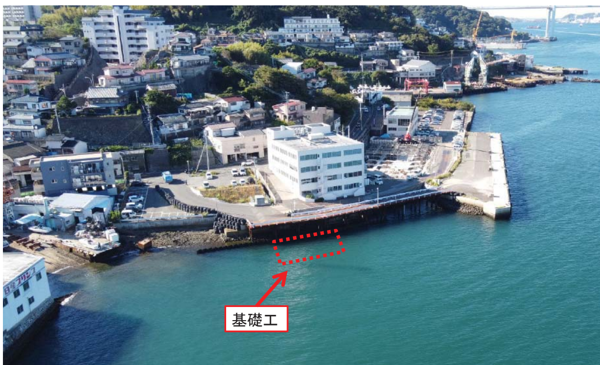
岸壁改良箇所現況
