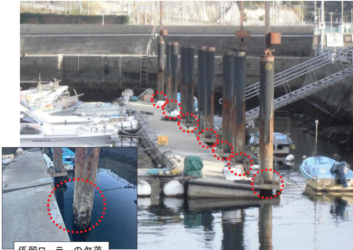
浮棧橋改良箇所の現況
