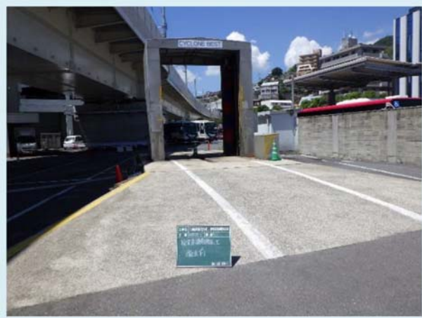
仮設洗車場撤去前
