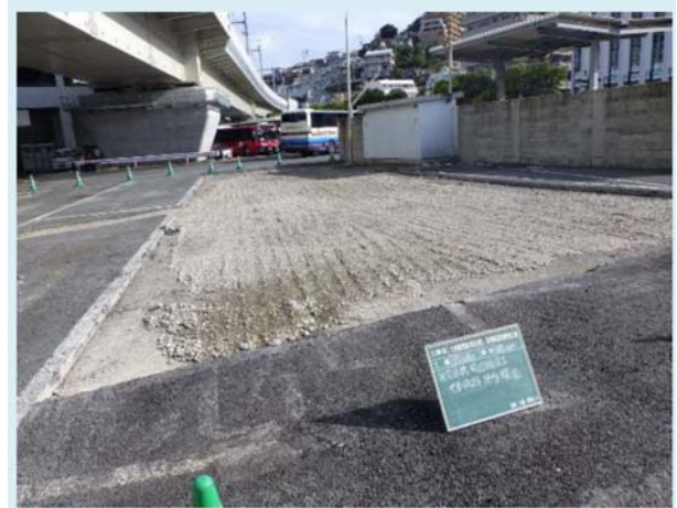
仮設洗車場撤去完了
