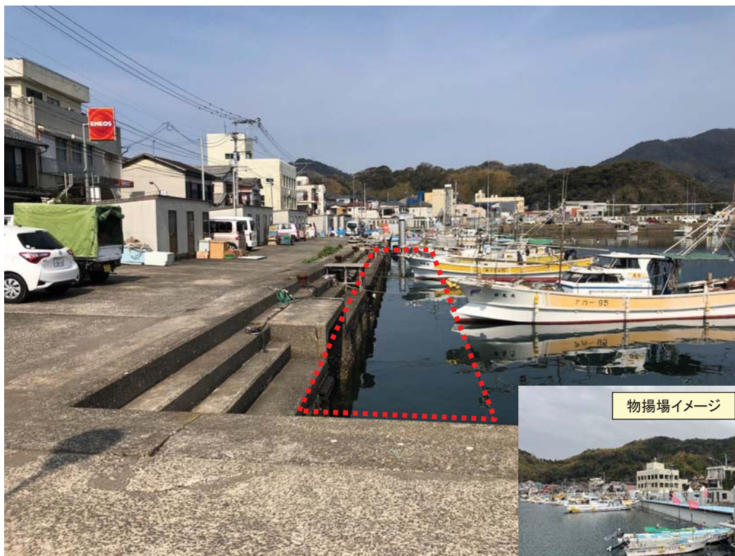
物揚場改良箇所の現況
