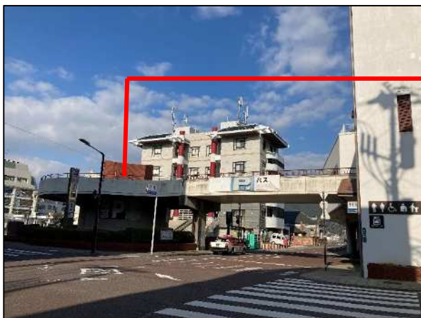
路面補修（2階（連絡通路））
