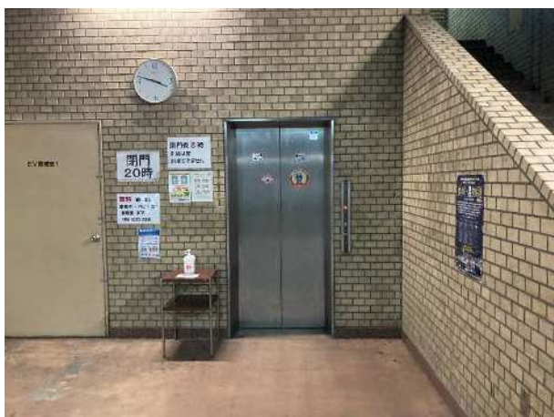
エレベーター更新 (1基目)
