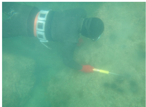
潜水による除去作業
