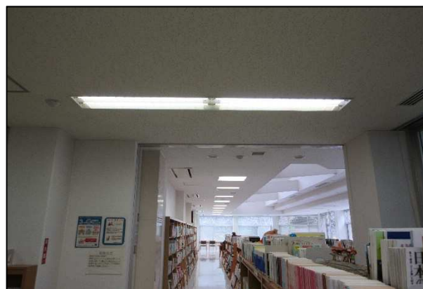
LED施工箇所例 (図書室)
