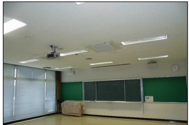
LED施工箇所例 (2階会議室)
