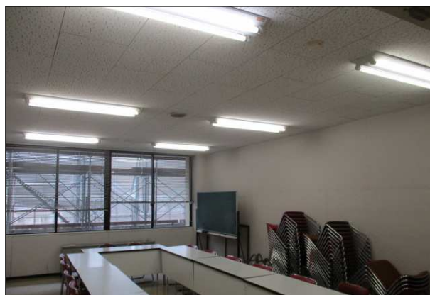
LED施工箇所例 (2階会議室)
