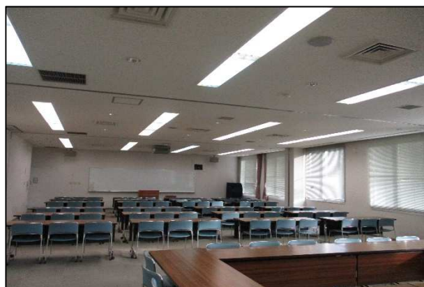
LED施工箇所例 (会議室)
