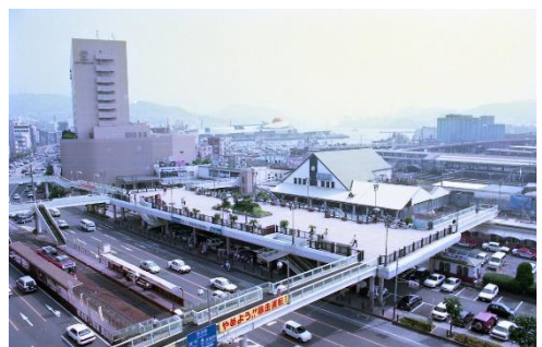
平成 10 年 7 月、三角屋根の駅舎が建つ J R 長崎駅周辺
