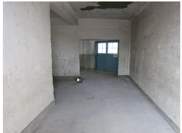
塔屋スペース
