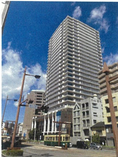
北街区(内装・外構工事中)
