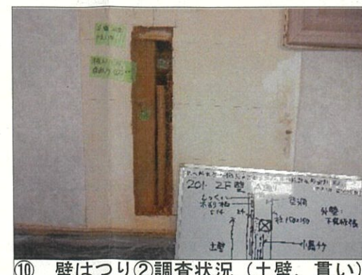
⑩ 壁はつり②調査状況 (土壁、貫)
