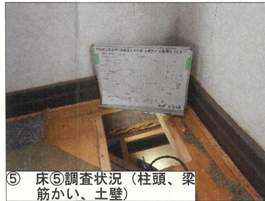
⑥ 床⑤調査状況 (柱頭、梁、筋かい、土壁)
