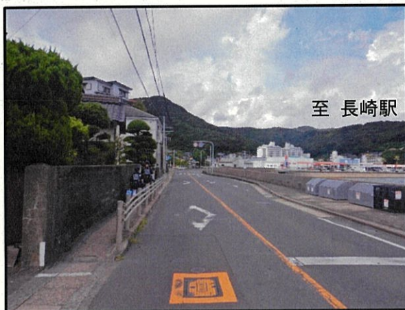
現況写真 (A工区・B工区)
