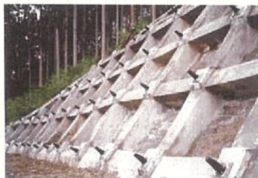
参考写真：現場吹付法砕工 グラウンドアンカー工
