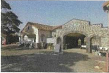
案内所・バラ園ゲートの外観の整備
