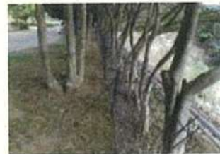
【ワイヤーメッシュを敷設】 損傷箇所がないか、定期的に点検しています。
