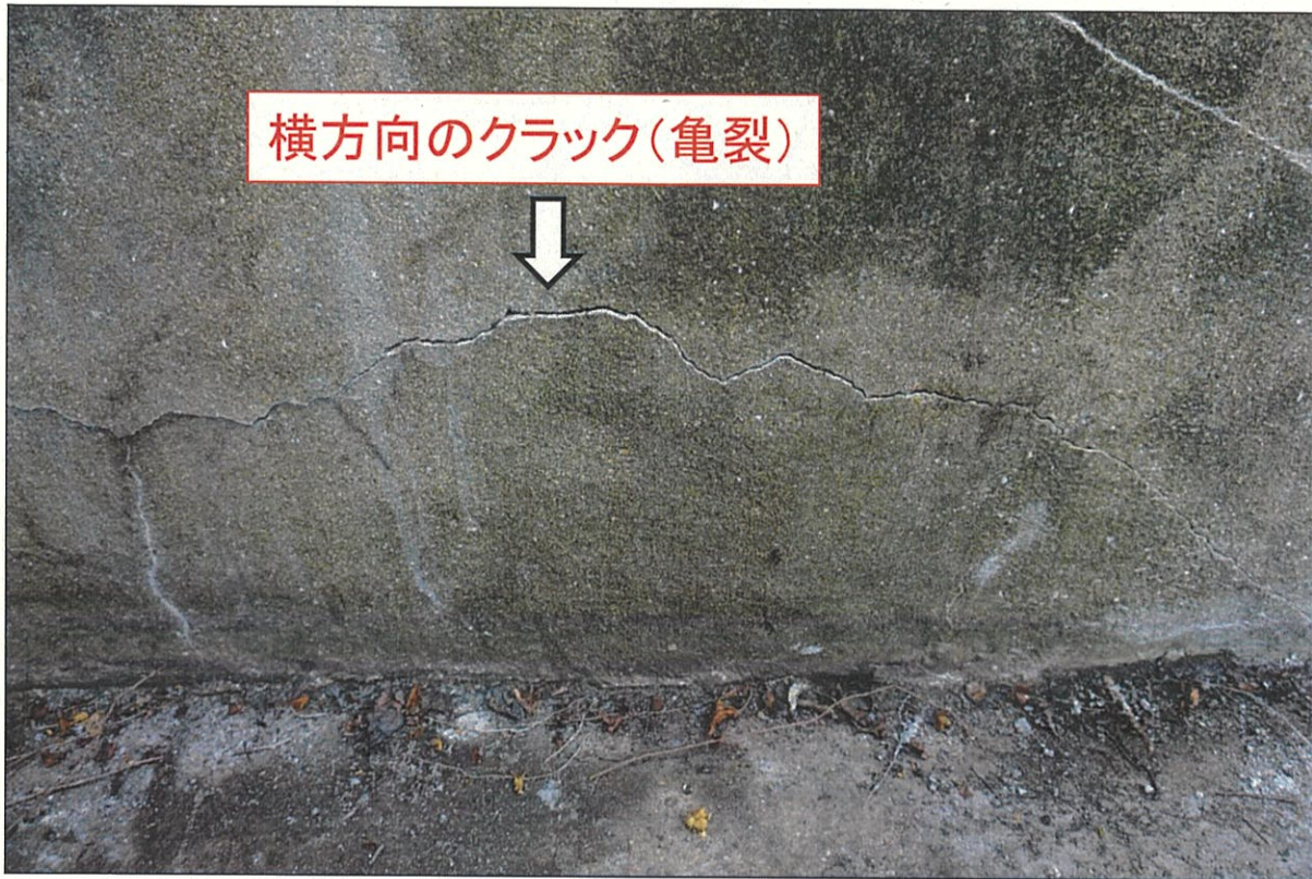
写真④ (南側擁壁外側)
