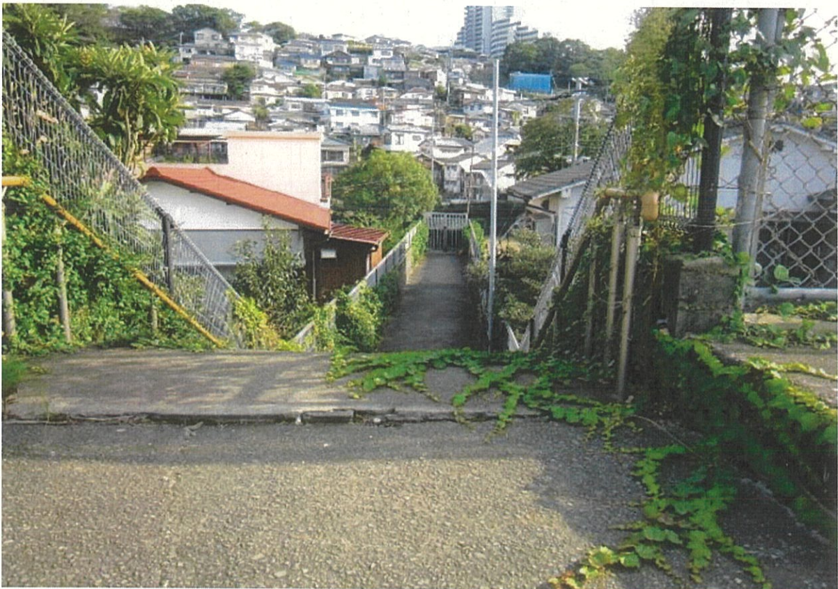
写真⑤ (南側擁壁から旧仁田佐古小運動場への陸橋)
