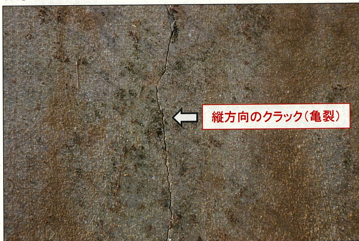
写真④ (南側擁壁外側)
