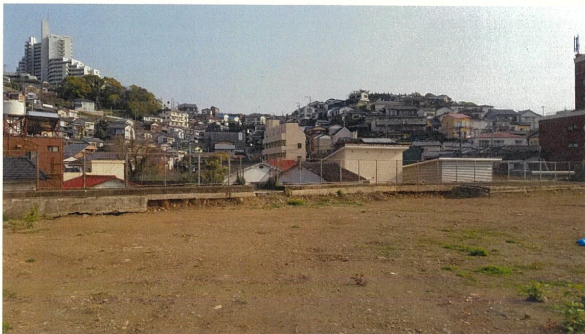
写真①（南側擁壁遠景）
